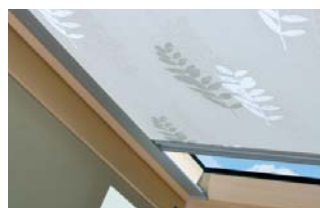
Las guías laterales permiten mantener la cortina a cualquier altura
